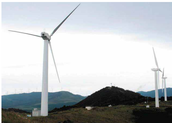
東伊豆町で故障した風力発電 (www.tokyo-np.co.jp)
